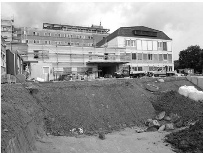
Es geht voran beim Neubau der Urologie der GRN-Klinik Eberbach. Foto: GRN
